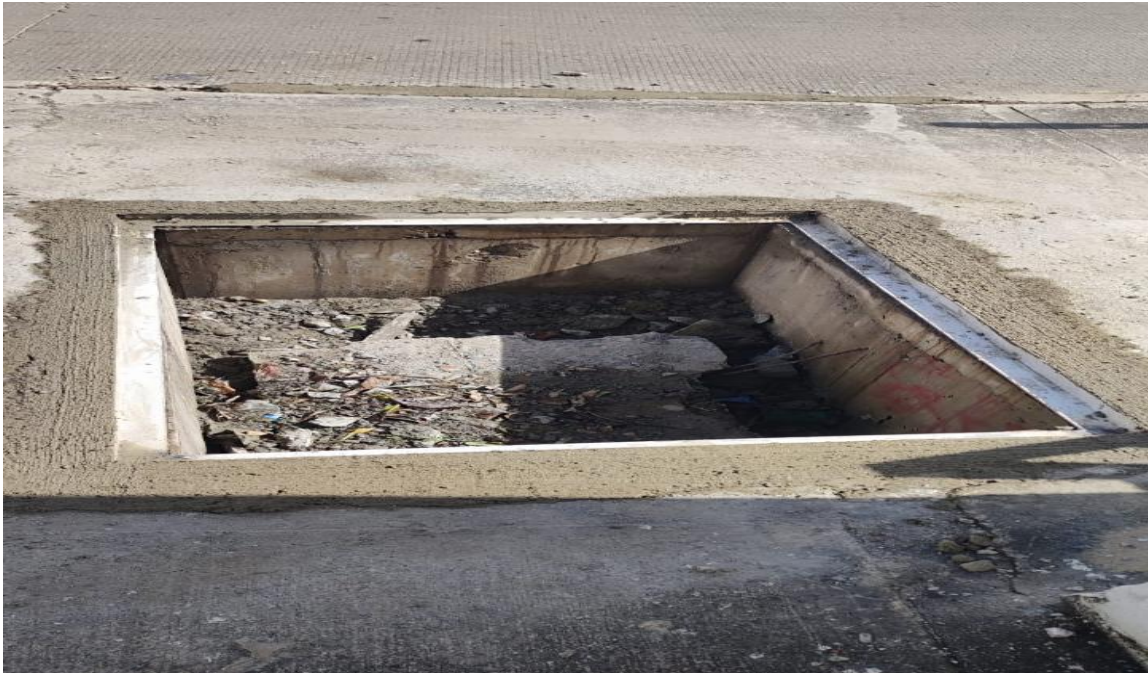
Fotografía 30. Retiro de obstrucción de registros.
