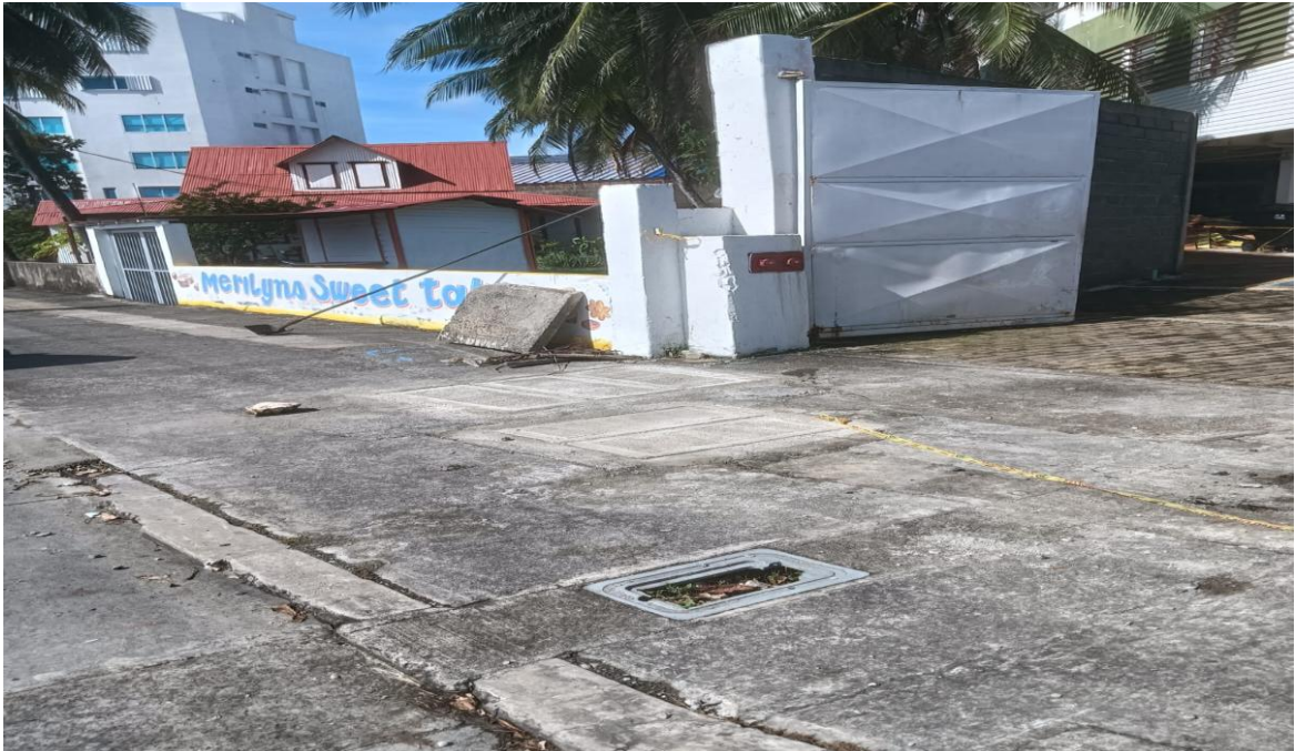
Fotografía 32. Construcción de tapas nuevas
