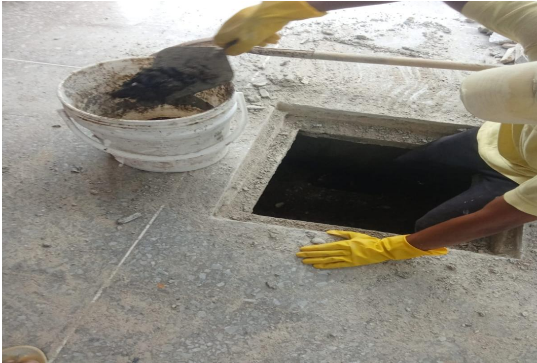
Fotografía 4. Limpieza de registros de aguas residuales
