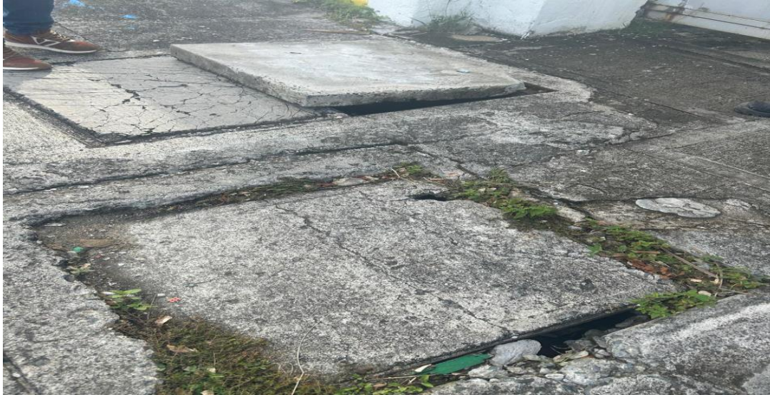
Fotografía 34. Tapas de registros anteriores deterioradas y en mal estado estructural
