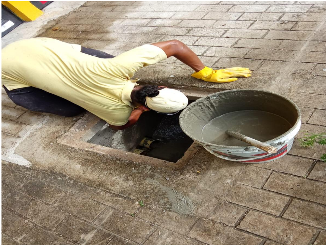
Fotografía 5. Mantenimiento de registros, impermeabilización.
