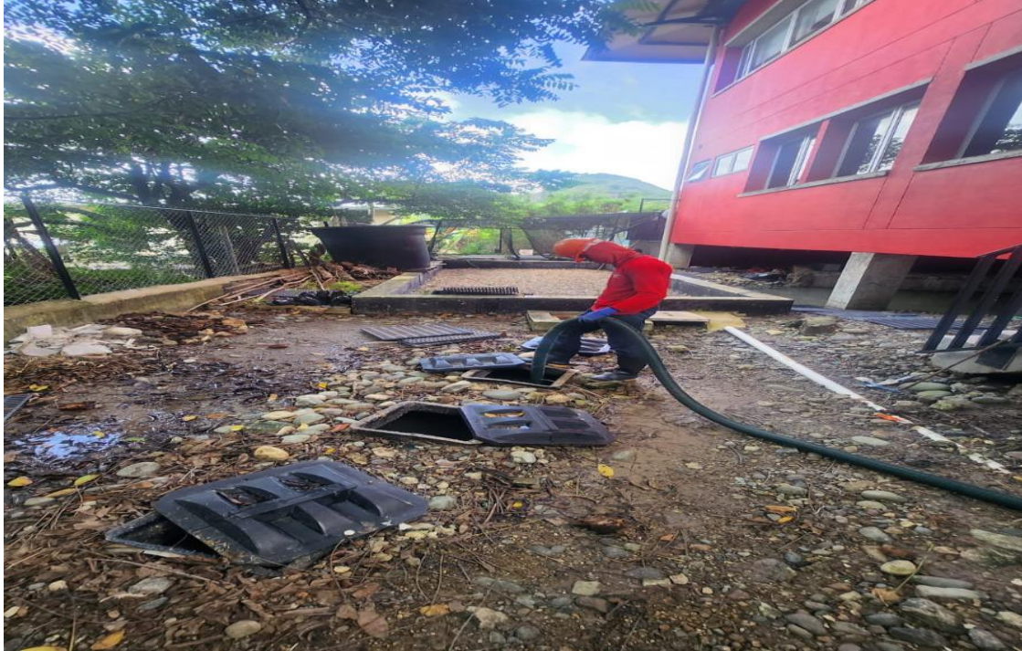
Fotografía 19. Limpieza y evacuación de aguas residuales de PTAR
