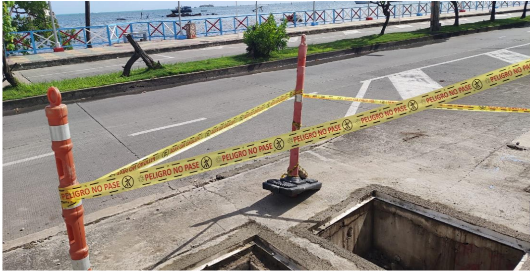
Fotografía 28. Implementación de señalización
