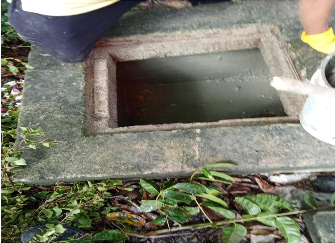
Fotografía 13. Mantenimiento de registros de aguas lluvias e impermeabilización
