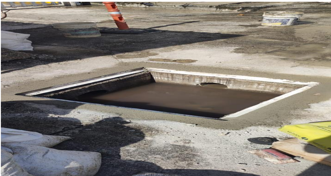
Fotografía 29. Evacuación de aguas residuales para limpieza y reconstrucción de tapas.
