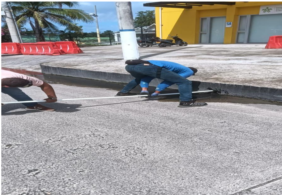
Fotografía 2. Limpieza de la Red de aguas residuales
