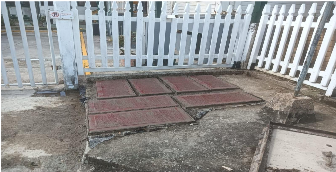
Fotografía 31. Construcción de tapas nuevas
