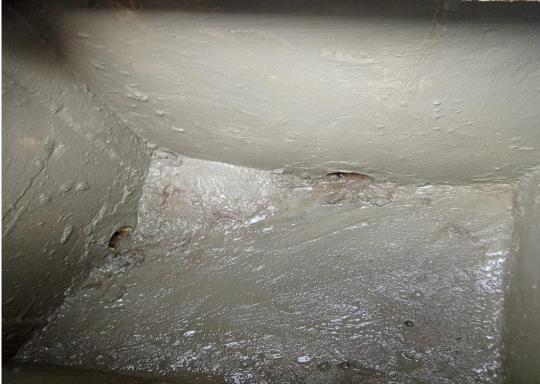
Fotografía 6. Mantenimiento de registros de aguas residuales, impermeabilización
