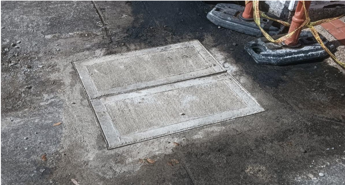
Fotografía 33. Construcción de tapas nuevas
