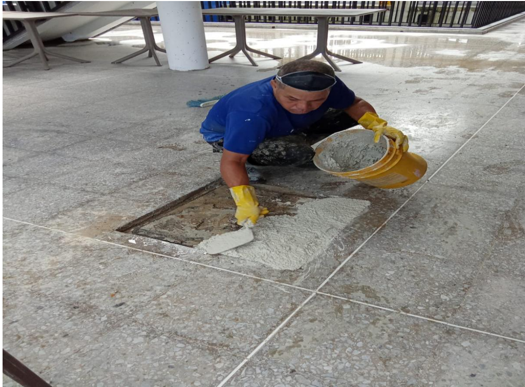
Fotografía 9. Reconstrucción de tapas de registros.
